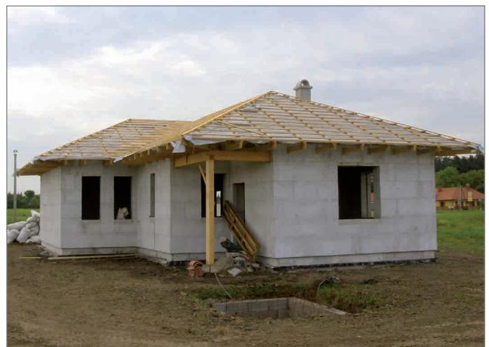
Die Gebäudekonstruktion eines Hauses mit einer Grundfläche von 100-120 m<sup>2</sup> wird unter idealen Bedingungen innerhalb von 16 Tagen fertig. Während der Montage vor Ort besteht die Möglichkeit, die Arbeiten an der Gebäudetechnik zu beginnen, sodass diese Technologie in bedeutendem Maße die Bauausführungszeit des Gebäudes beschleunigt.
